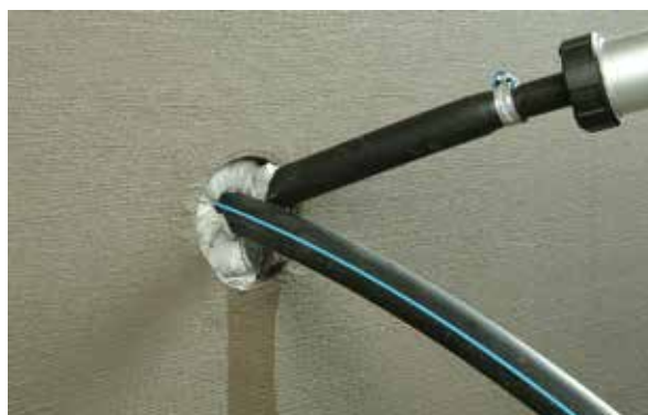
Затем пистолетом нагнетается KÖSTER KB-Flex.
