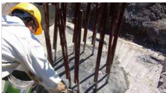
Нанесение KÖSTER NB 1 Grey
