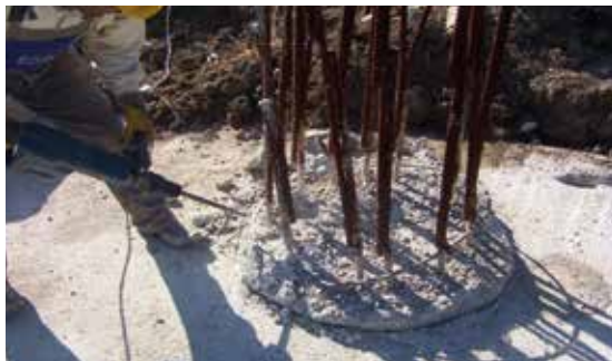
Удаление выступов и очистка оголовка сваи
