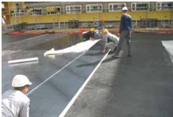
Гидроизоляция мембранами KÖSTER KSK
