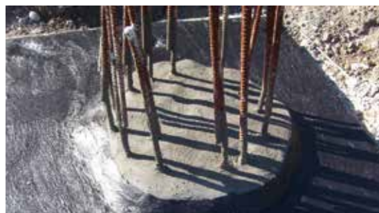
Подведение поверхностной гидроизоляции (KÖSTER Deichan 2C) к гидроизоляции оголовка сваи
