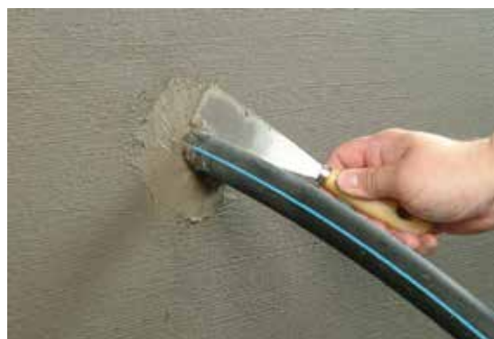
В качестве защитного слоя наносится KÖSTER KB-Fix 5.
