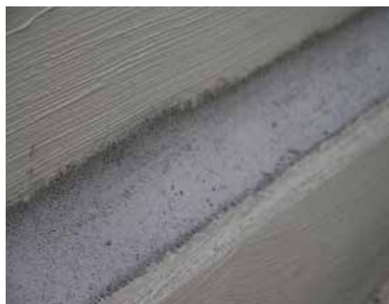
Закругленная галтель из раствора KÖSTER WP Mortar
