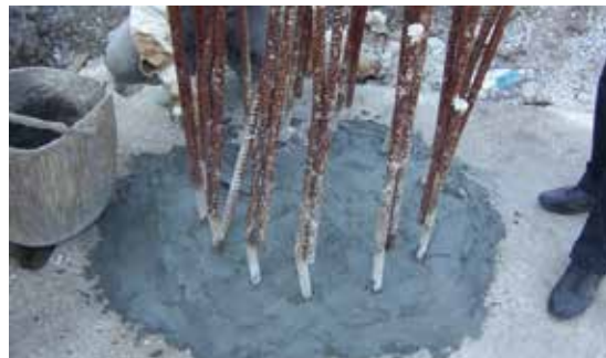
Установка галтели и выравнивание поверхности ремонтным раствором KÖSTER WP Mortar.
