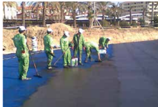
Гидроизоляция с KÖSTER Deuxan 2C.
