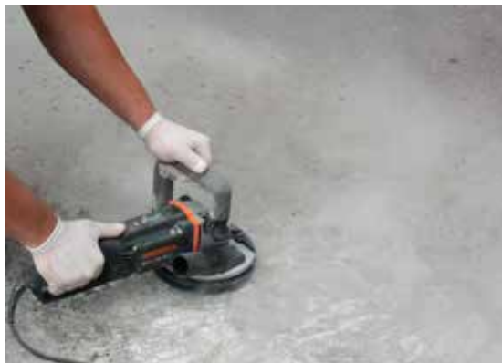
1. Подготовка поверхности
