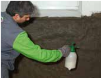
Grundieren mit KÖSTER Polysil® TG 500
