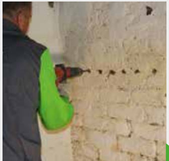
Waagerechte Bohrung in die Lagerfuge
