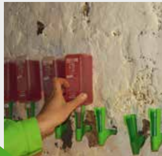
Einsetzen der Kartuschen
