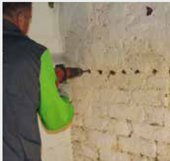
Waagerechte Bohrung in die Lagerfuge
