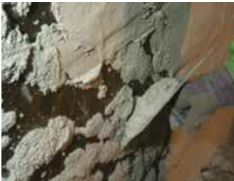
Aufbringen des KÖSTER Sanierputzes
