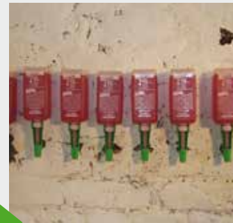
Selbständige Installation der Horizontalsperre
