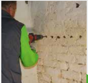
Waagerechte Bohrung in die Lagerfuge
