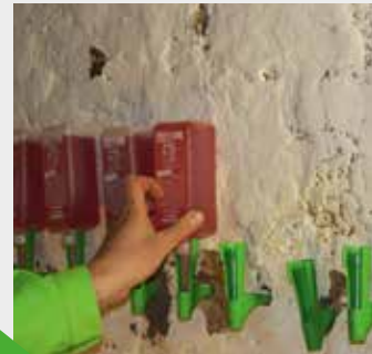
Einsetzen der Kartuschen
