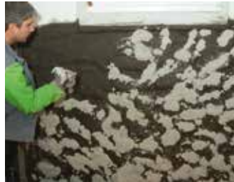
Aufbringen des KÖSTER Spritzbewurfs
