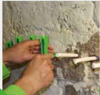
Einsetzen der KÖSTER Kapillarstäbchen und der KÖSTER Saugwinkel
