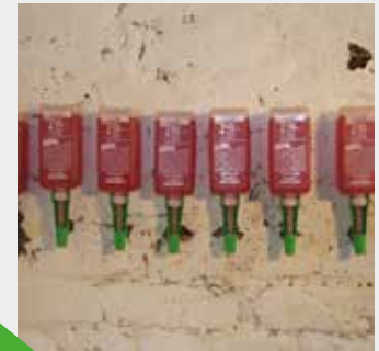
Selbständige Installation der Horizontalsperre
