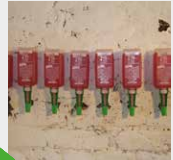
Selbständige Installation der Horizontalsperre
